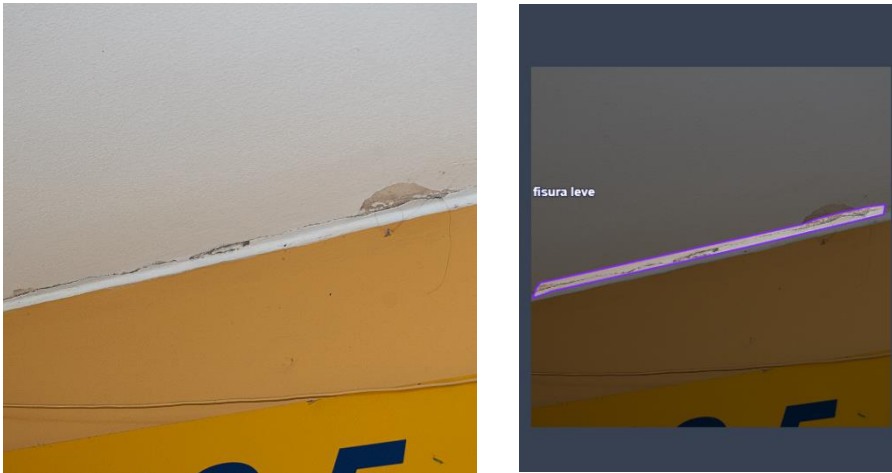
Figura 22. Identificación de Fisura leve
