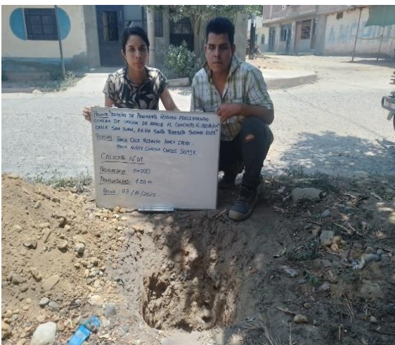
Figura 9: Excavación de calicata n°1.
