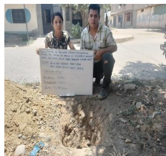
Figura 5. Excavación de Calicatas.
