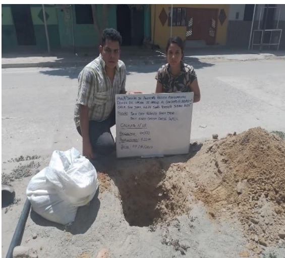
Figura 11: Excavación de calicata n°3.
