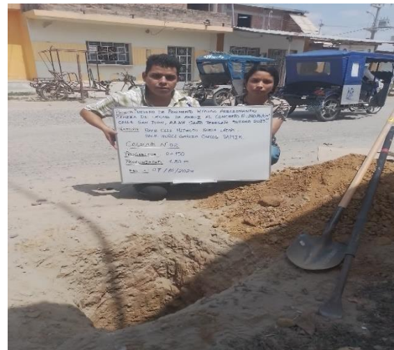
Figura 10: Excavación de calicata n°2.
