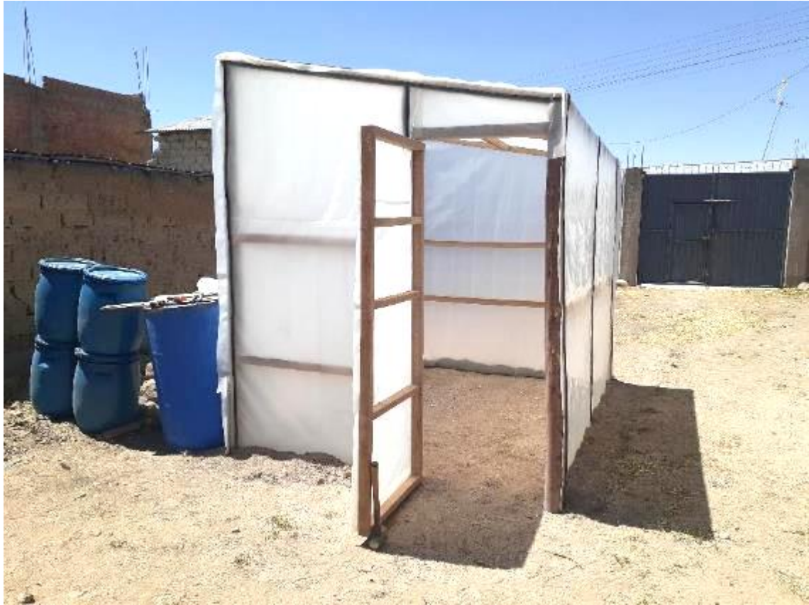
Foto N° 03: Instalación de la cobertura de agrofilm del invernadero
