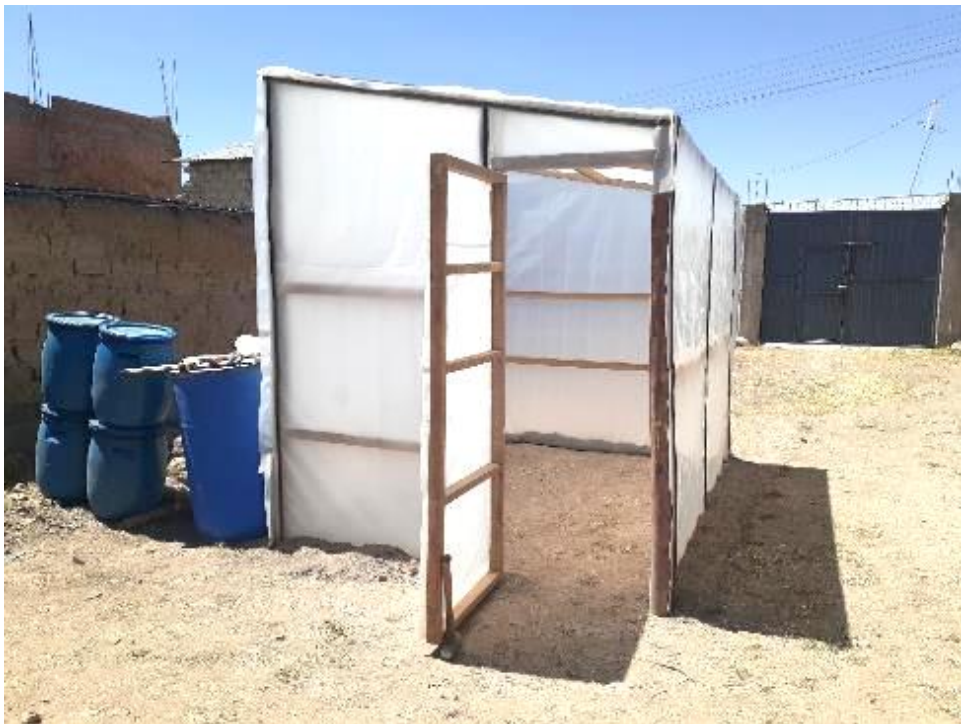
Figura N° 3: Invernadero construido para el proceso de biodigestión
