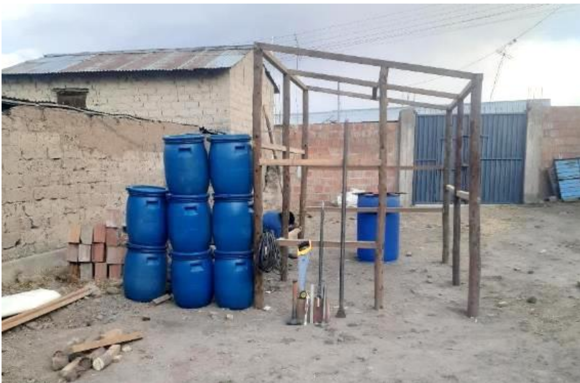
Foto N° 02: Construcción del armazón del invernadero
