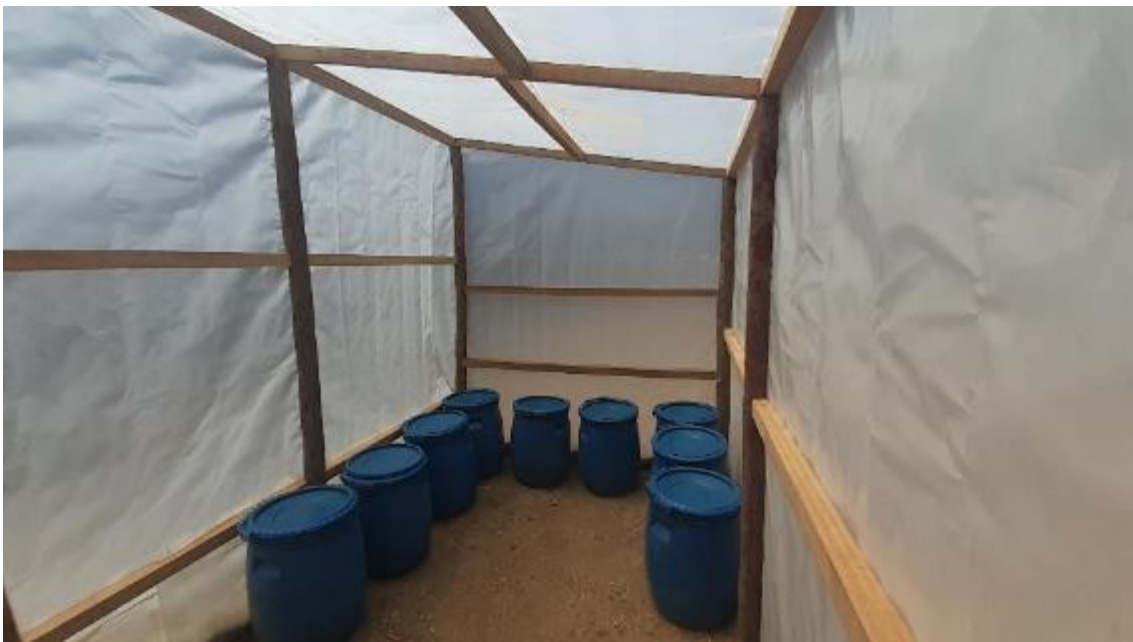
Foto N° 04: Ubicación de los 09 barriles que se usaron como biodigestores
