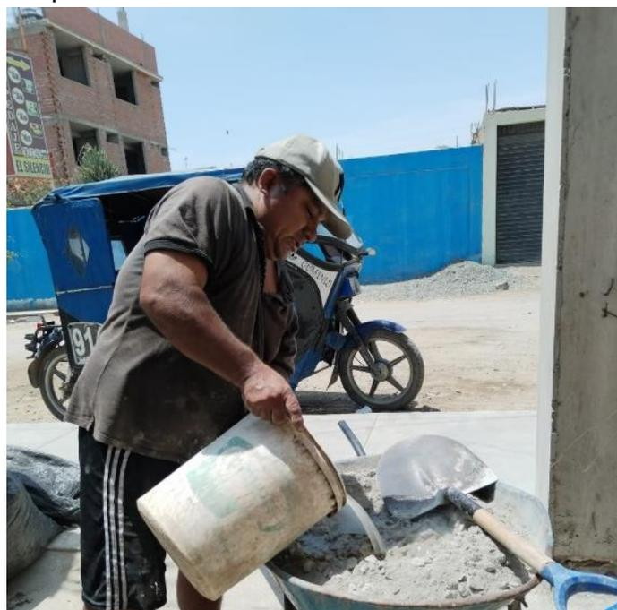
**FOTOGRAFÍA N° 20, 21 y 22:** Prueba de consistencia de mezcla patrón
