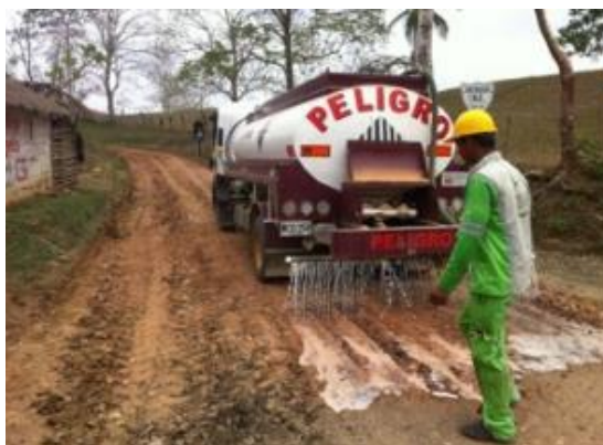
Figura 2: Aplicación de aditivo Ionicsoil (Ficha técnica Optimasoil 2020)
