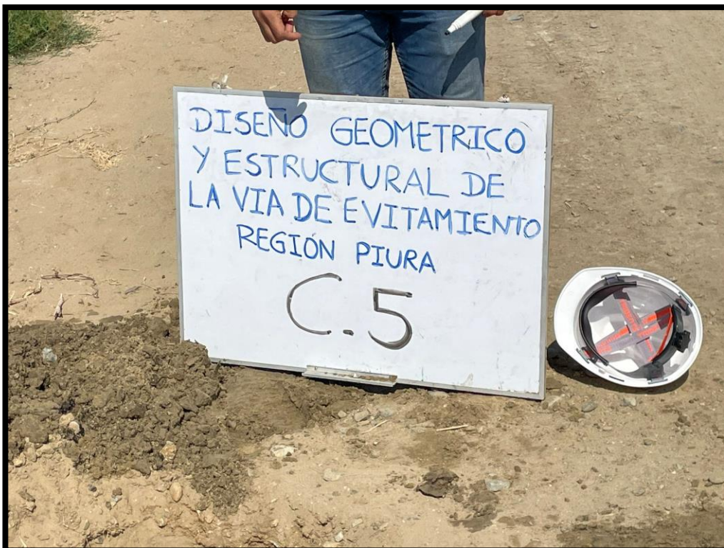
Calicata N°05 extraída en la progresiva 5+050 km – dimensiones 1.00*0.60*1.50
