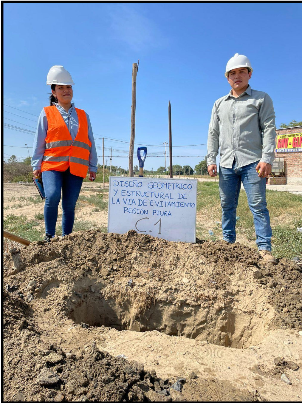
Calicata N°01 extraída en la progresiva 0+050 km – dimensiones 1.00*0.60*1.50
