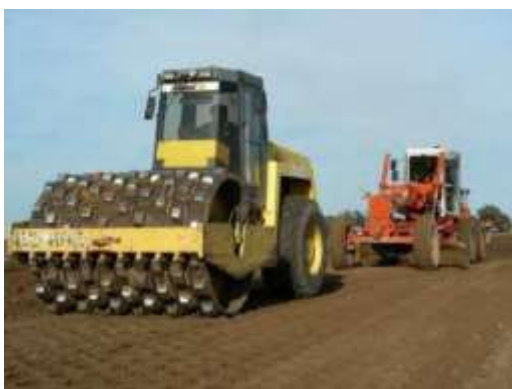
Figura 04. Consolidación por compactación mediante maquinaria pesada.
