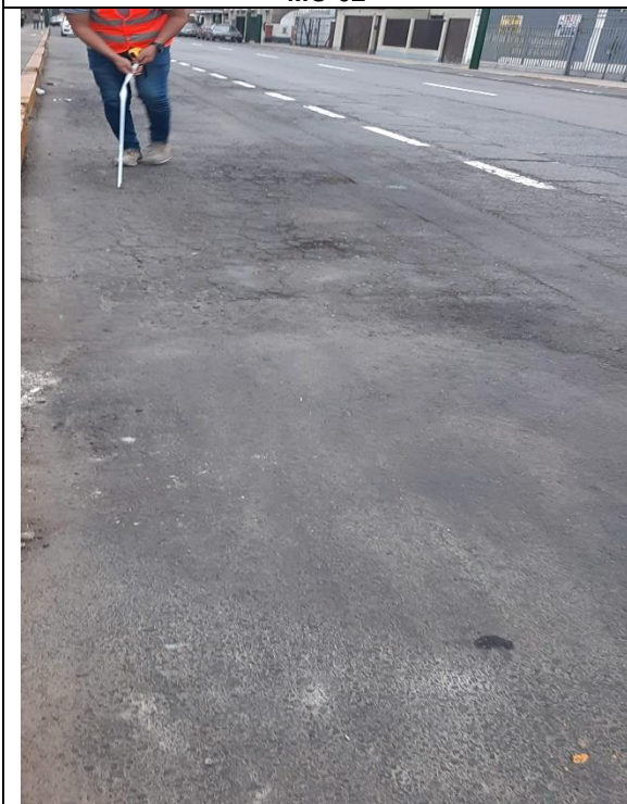
Figura 03: Piel de cocodrilo Nivel de Severidad: Alta MU-07
