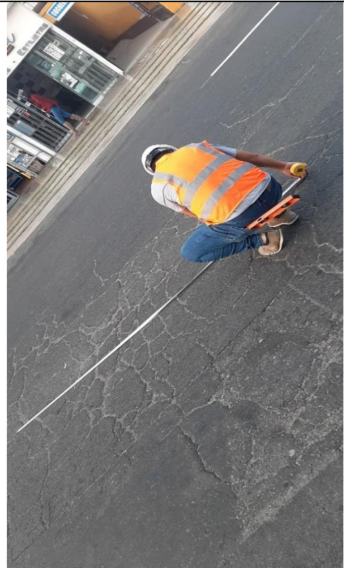
Figura 06: Piel de cocodrilo Nivel de Severidad: Media MU-07
