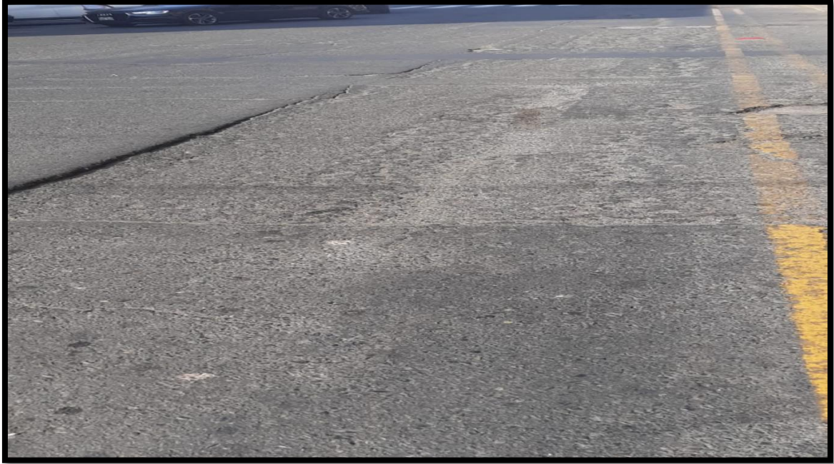
Figura 2 Ahuellamiento
