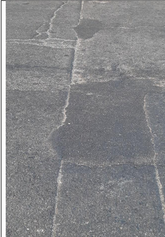
Figura 05: Parcheo Nivel de severidad: Alta MU-09
