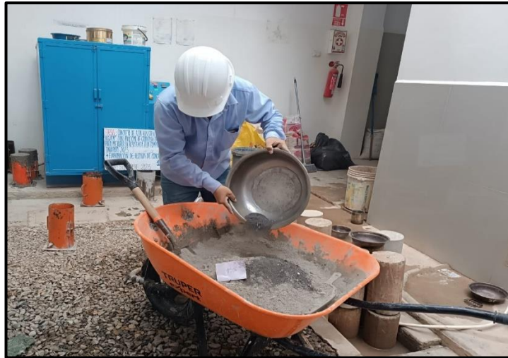
Fotografía 17: Prueba Slump con adición del 5% de aditivo
