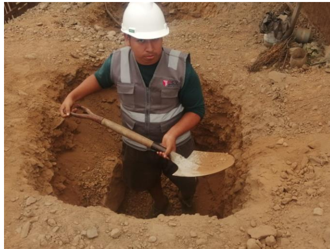
Figura 6 Excavación de calicata
