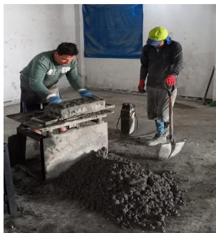
Figura 10 Compactación de la mezcla
