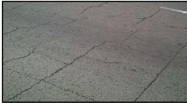
**Figura 03:** Fisura en losa de concreto
