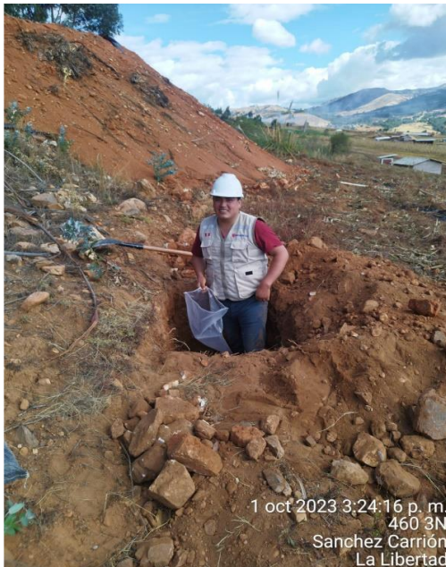
Excavación de la calicata N° 02
