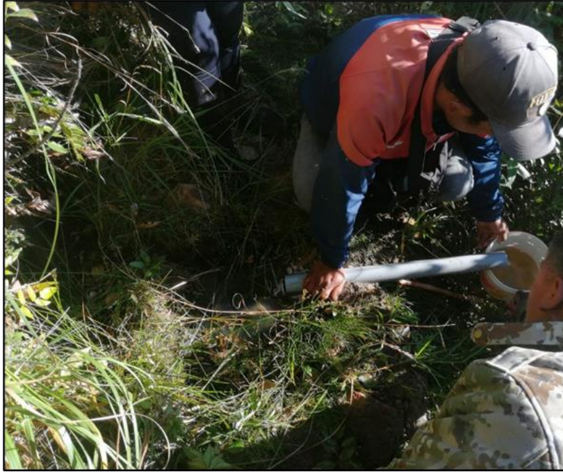
Figura 10. Aforamiento de Captación N°03 La Ladera – Sector Quinualito.
