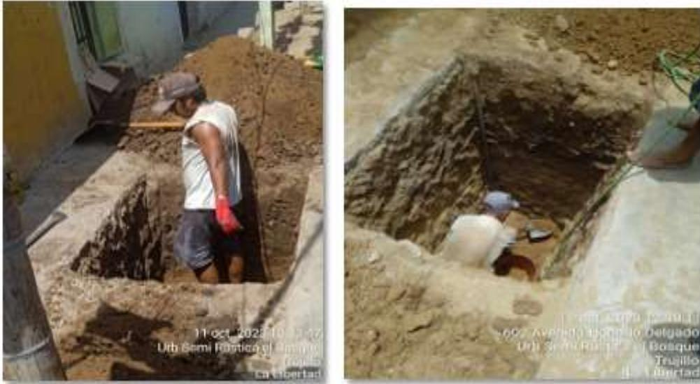
Figura 05: Excavación de calicata
