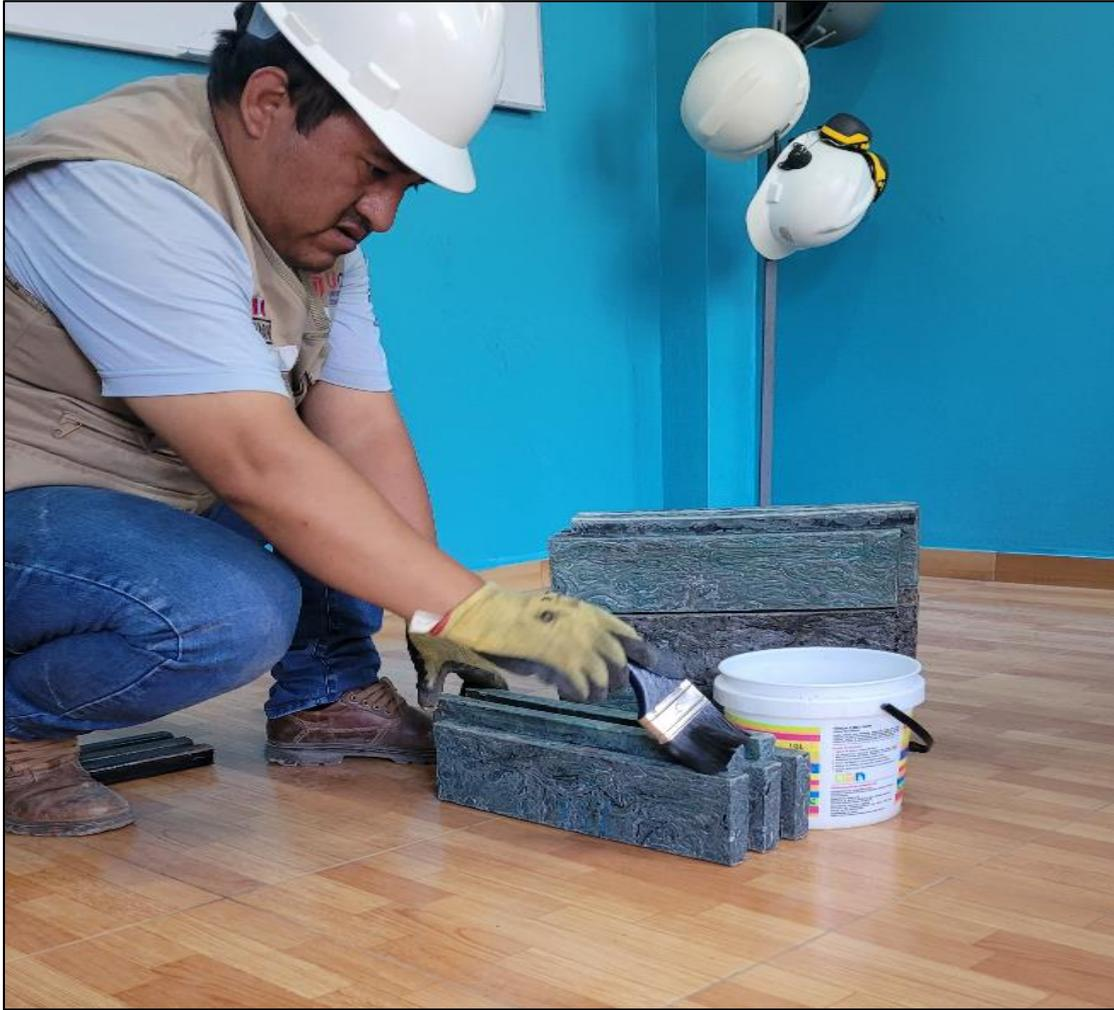
*Figura 21. Pegamento vinílico con una brocha de 4" en las uniones con guía de los ladrillos.*
