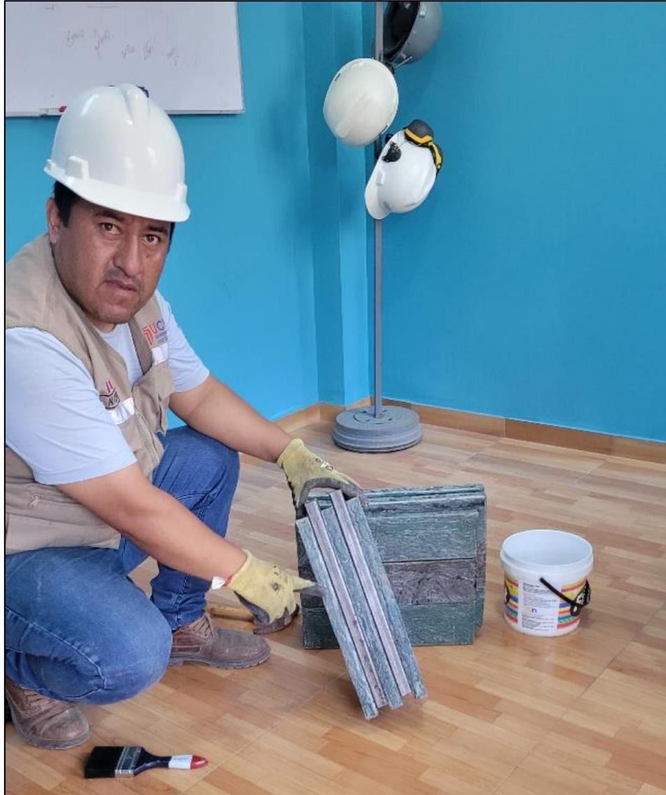
*Figura 20: Se colocan perfiles de 1"x1"x2.8mm en canaletas inferiores del primer ladrillo para una adecuada distribución de las cargas.*
