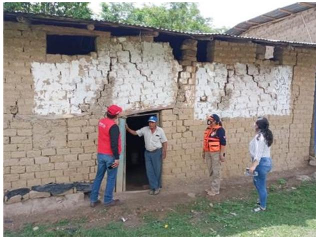
*Figura 1.* Agrietamiento y fisuras en muros de adobe
