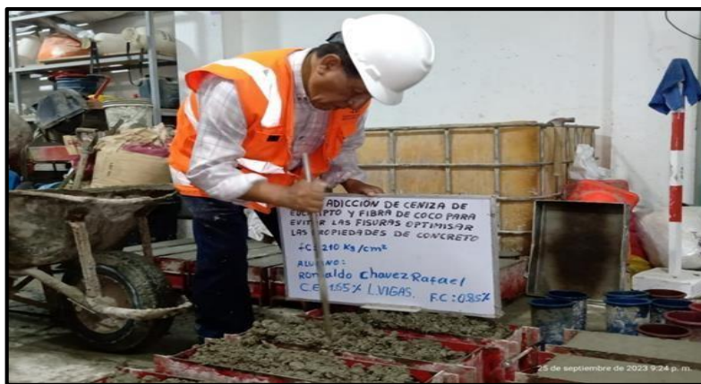
Figura 13. Curado del concreto
