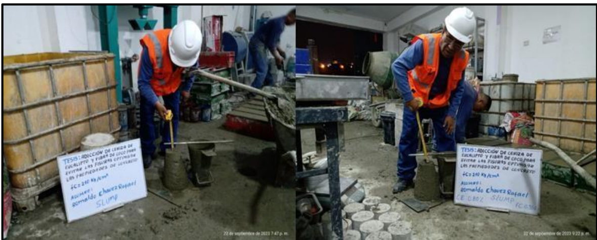
Figura 11. Asentamiento del concreto
