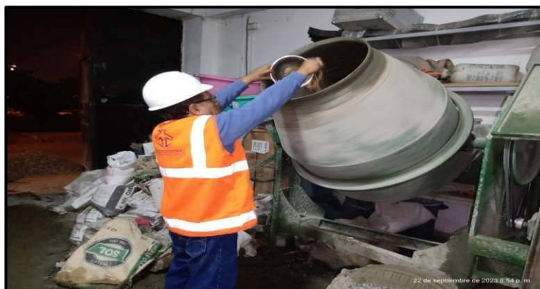
Figura 10. Concreto f'c = 210 \text{ kg/cm}^2
