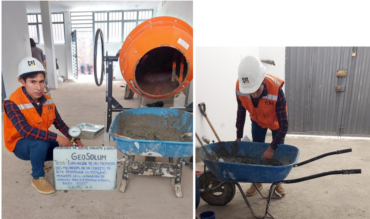
Preparación de la mezcla de concreto, haciendo uso de la mezcladora tipo tambor.
