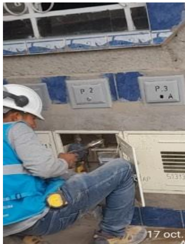
Figura 7. Colocación del medidor
