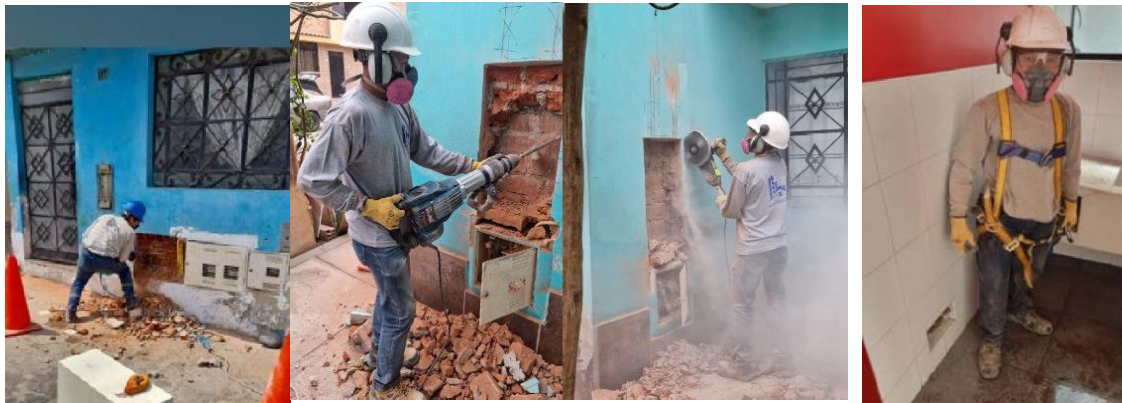
Figura 17. Trabajos que se realizan para la instalación
