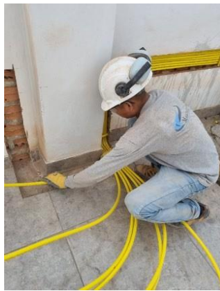
Figura 4. Tendido en la tubería
