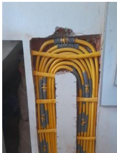
Figura 4. Tendido en la tubería
