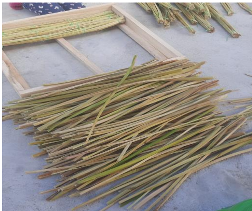
Figura 19. Incorporación de la Totora al sistema del panel.
