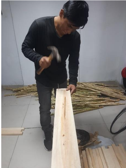
Foto 13: Fabricación del panel.
