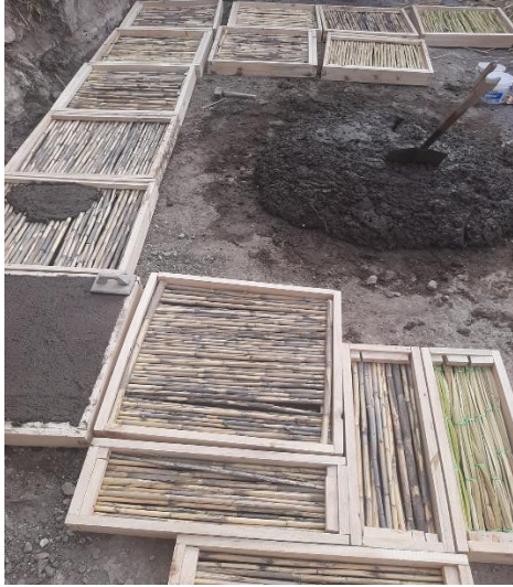
Foto 1: Revoque, paneles de quincha.
