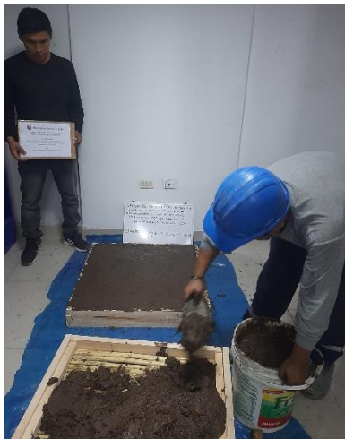
Foto 15: Aplicando el revoque.
