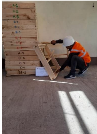
Figura 17. Elaboración de los paneles de Quincha y Totora.
