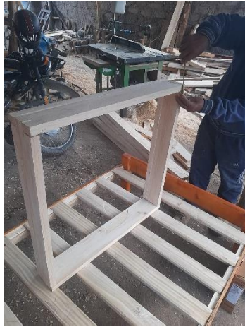
Figura 16. Elaboración de los paneles de Quincha y Totora.
