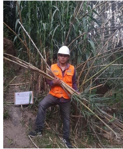
Figura 9. Extracción de la Quincha.
