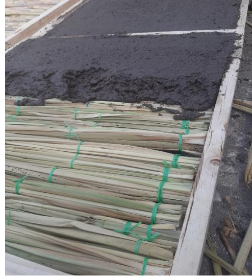
Foto 2: Revoque, paneles de totora.
