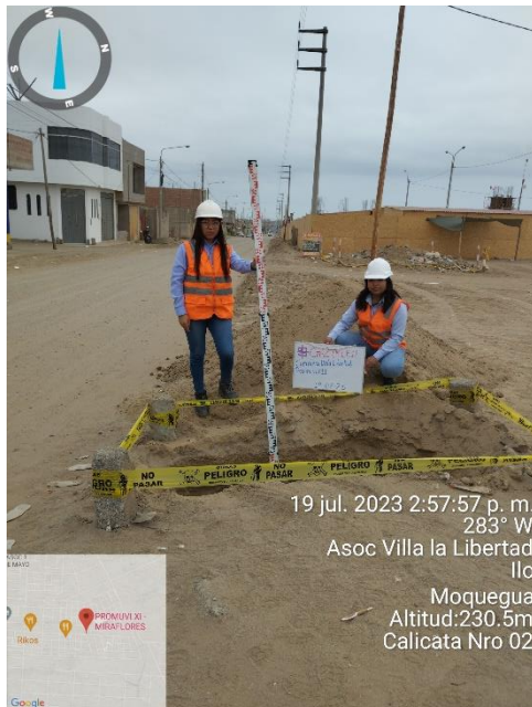
Fotografía 7. Excavación de la Calicata 2.
