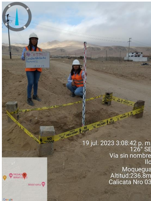
Fotografía 11. Excavación de la Calicata 3.
