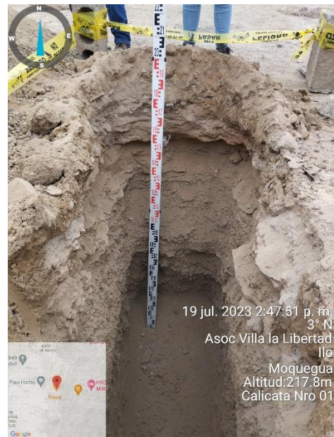
Fotografía 4. Identificación de profundidad de la Calicata 1.
