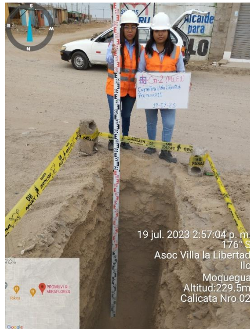
Fotografía 8. Identificación de profundidad de la Calicata 2.
