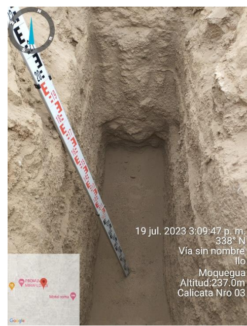
Fotografía 12. Identificación de profundidad de la Calicata 3.
