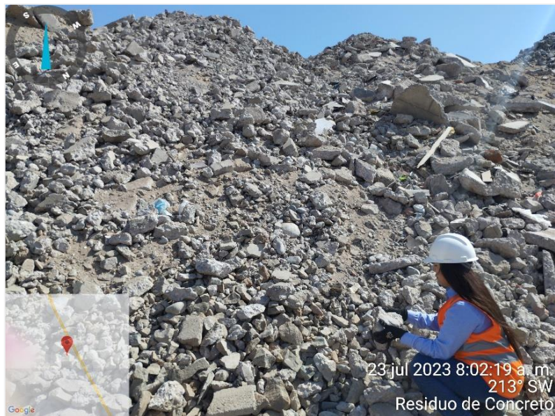
Figura 15. Extracción de Residuos de Concreto.
