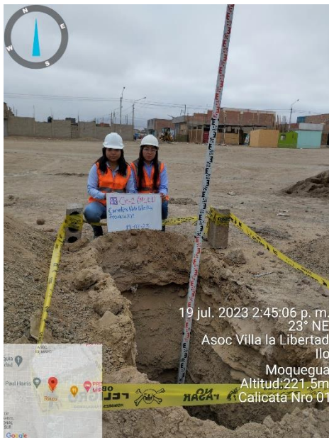
Fotografía 3. Excavación de la Calicata 1.
