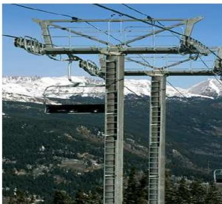
Ilustración 3.48: Sistemas de soporte del teleférico
