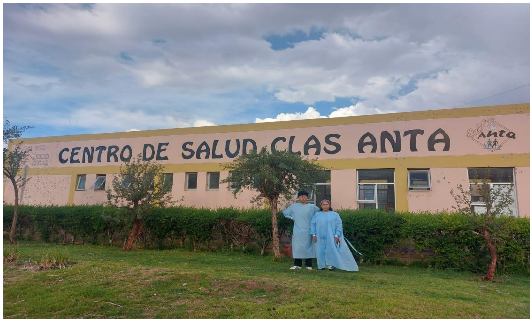
fotografía de las instalaciones del centro de salud CLAS Anta
