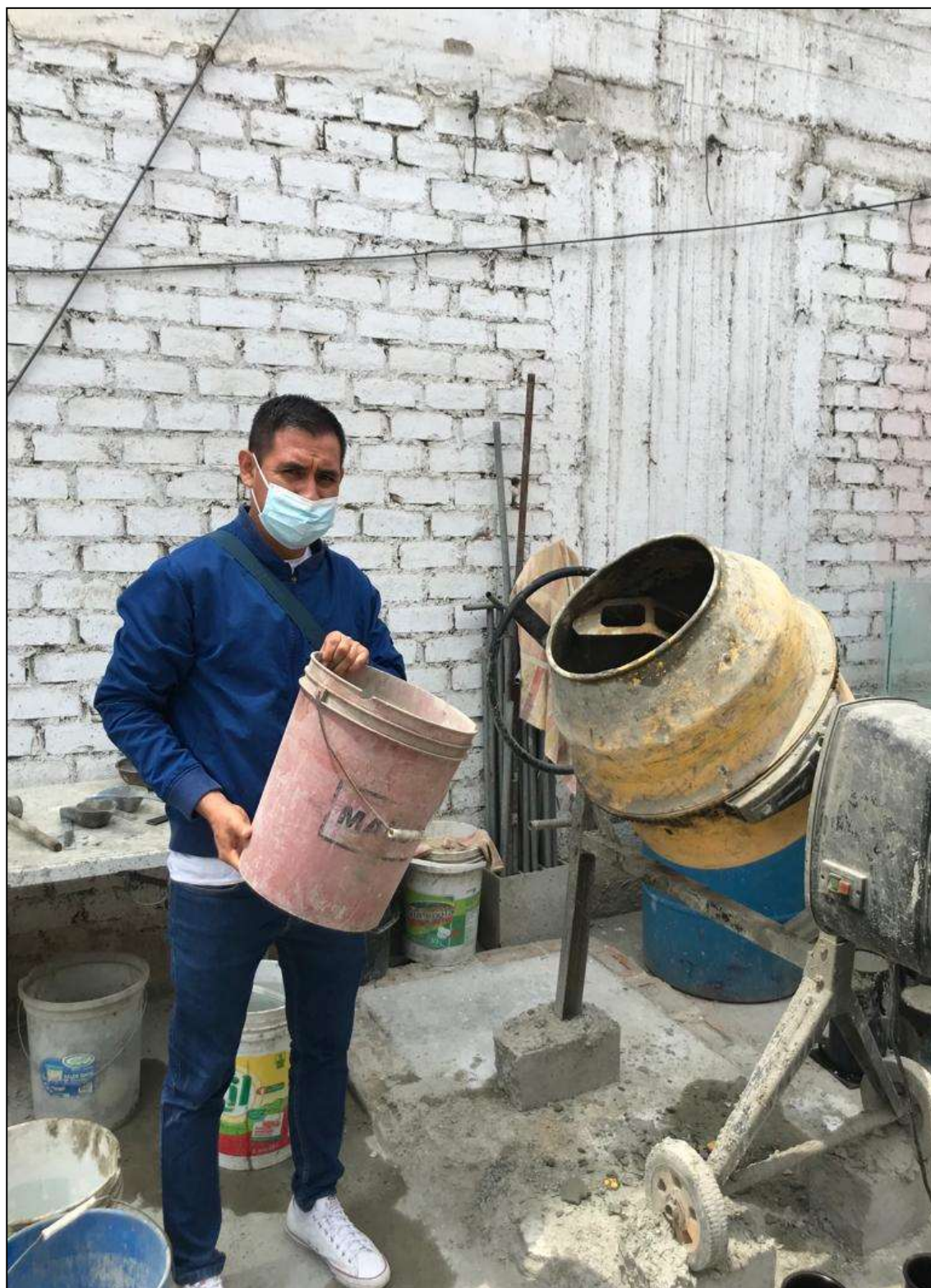
Preparación del concreto
