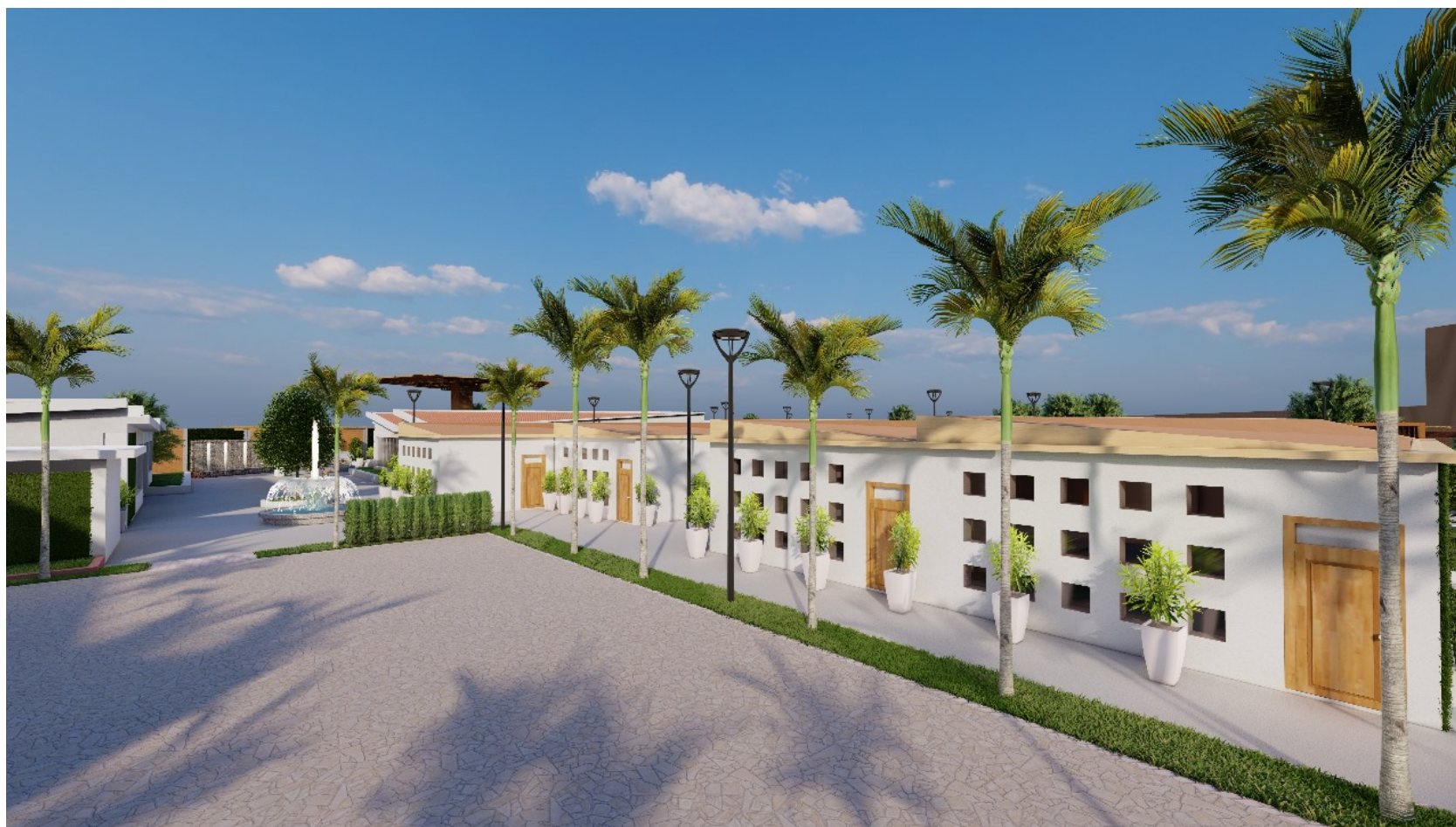
Figura 71: Vista frontal de las aulas
