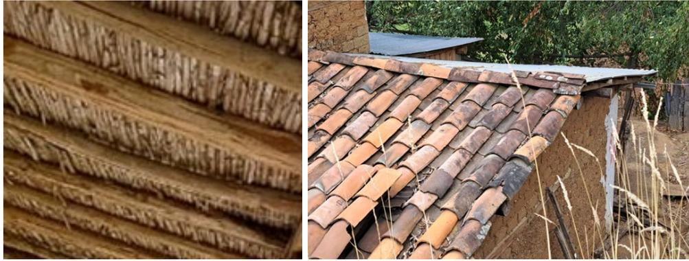
Figura 26. Acabado constructivo del techo con carrizo y teja.
