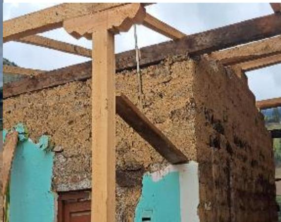
Proceso constructivo del techo de las viviendas, colocando la madera sobre el adobe, y posteriormente el carrizo con el barro para colocar la teja.
