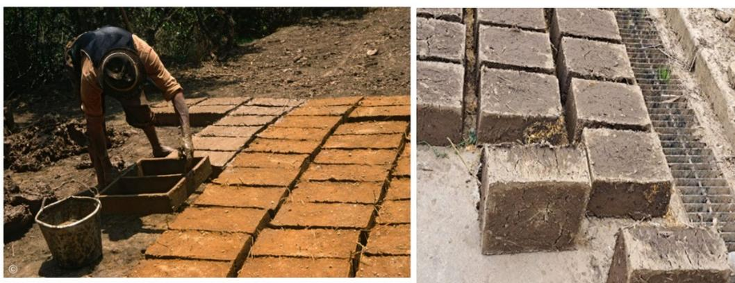
*Figura 24.* Proceso constructivo de los ladrillos de adobe.
