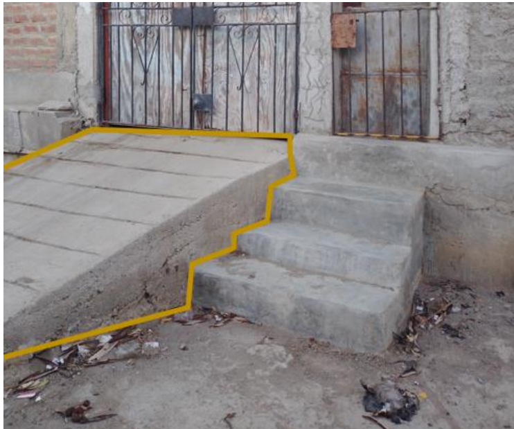
Figura 14- Rampas en viviendas
