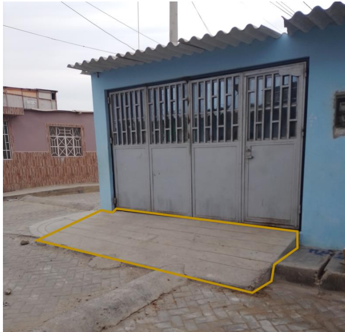
Figura 13- rampas en viviendas
