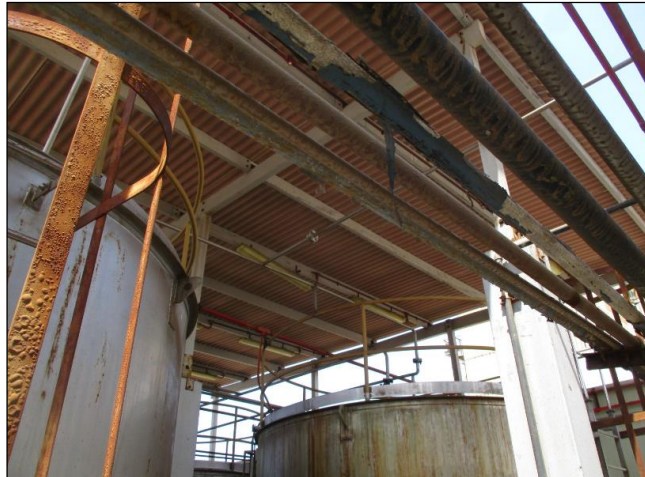
Figura 11. Ubicación del tendido de tubería, su carga, descarga y desfogue del sistema NAC SAC.
