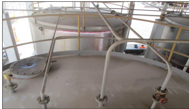
Figura 12. Tendido de tubería del sistema NAC SAC.
