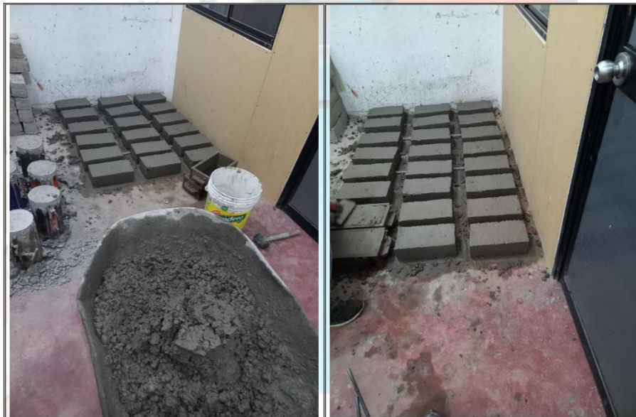
Fotos nº 23-24: En las imágenes podemos observar el moldeo de los bloques de concreto.
