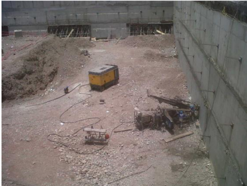
Figura 30. Perforación continua sobre muros ya vaciados
