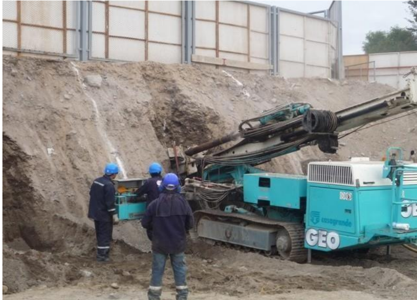
Figura 28. Perforación continua sobre la banqueta
