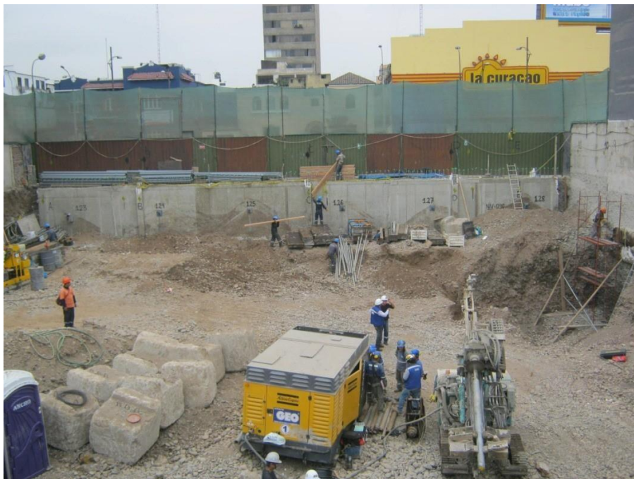
Figura 33. Primer nivel tensionado
