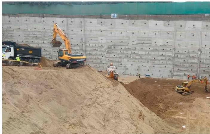
Figura 2. Excavación masiva
