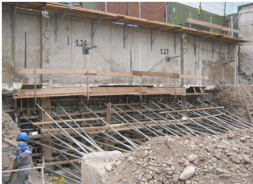
Figura 35. Encofrado de muros
