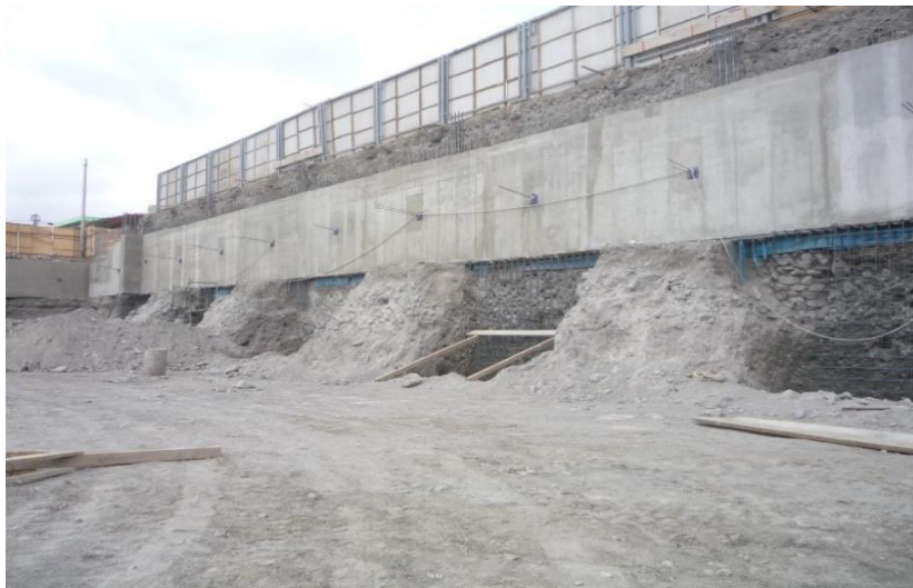
Figura 29. Perforación intercalada
