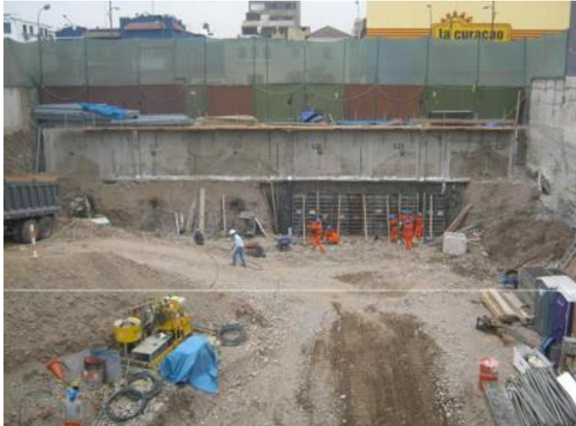
Figura 36. Encofrado y vaciado de muros
