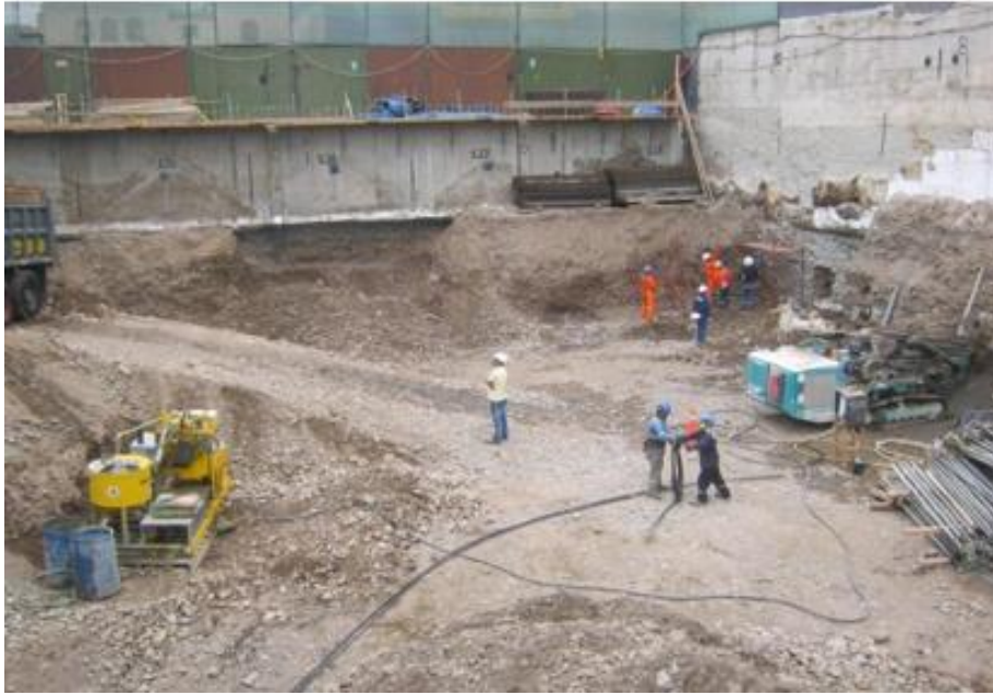
Figura 34. Excavación de muros de segundo nivel
