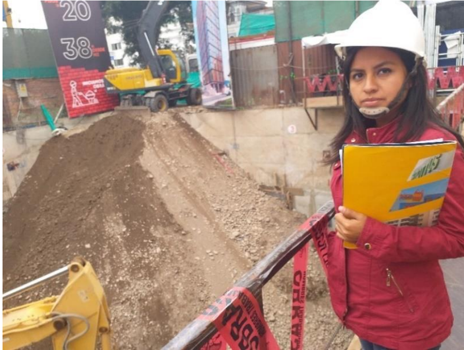
Figura 7. Visita a la obra IQ Lince.
