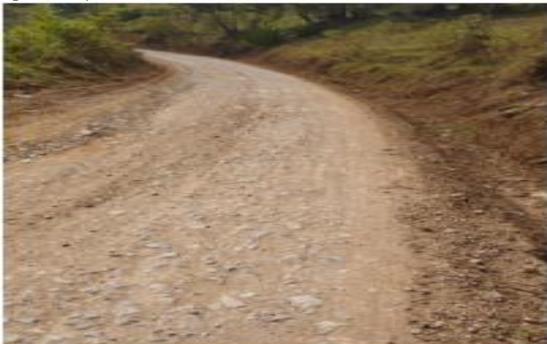
Figura 9: Superficie de rodadura
