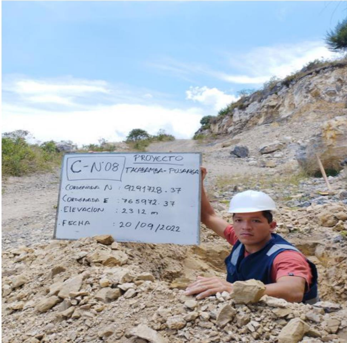
Imagen 4 : Tacabamba, escabacion y estracion de muestra de la calicata C-8 , Septiembre 2022
