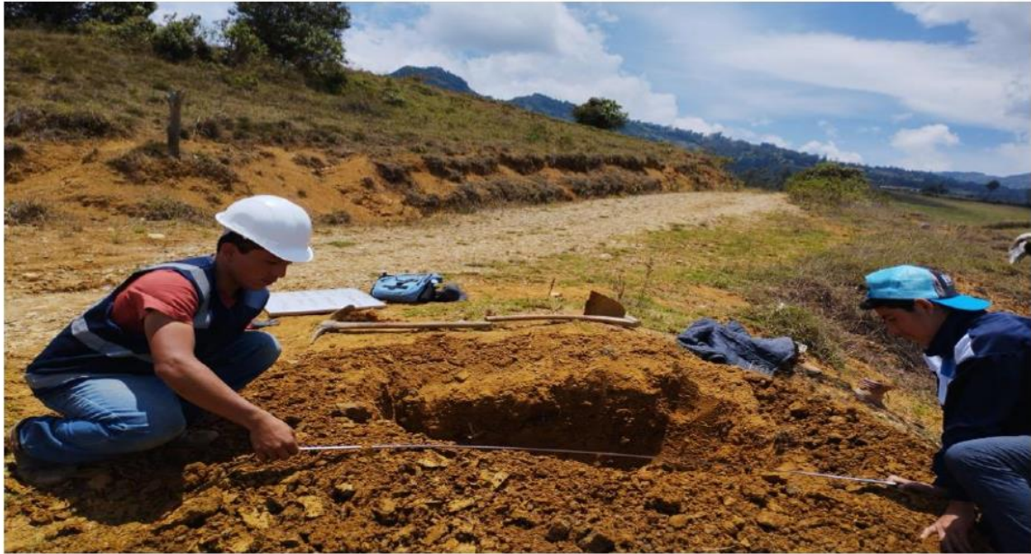
Imagen 2 : Tacabamba, medicion y escabacion de la calicatas C3 y C4 , Septiembre 2022
