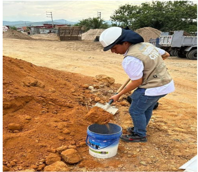
Foto N° 01 y N° 02: En las imágenes se puede apreciar el muestreo de los materiales a utilizar de cantera.
