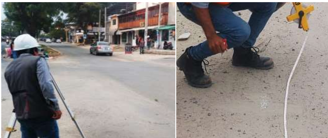
Figura 6. Verificación de altura de instrumento y marcado de puntos.
