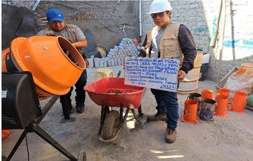
FIGURA 6: Elaboración del concreto f'c=210\text{Kg/cm}^2 en la mezcladora.
