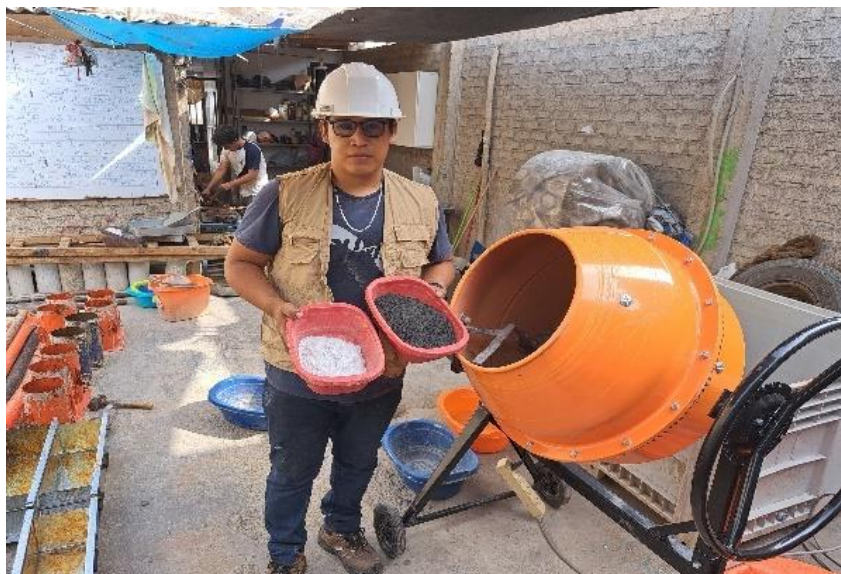
FIGURA 7: Elaboración del concreto con adición de CTM y yeso
