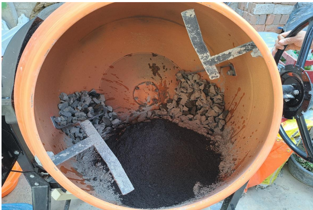
Fotografía 15: fabricación del concreto
