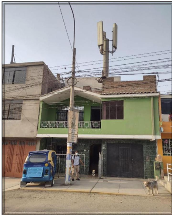
Figura 14. Edificación de albañilería confinada
