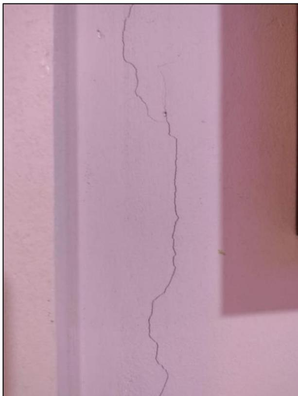
16. Presencia de fallas en columnas de confinamiento
