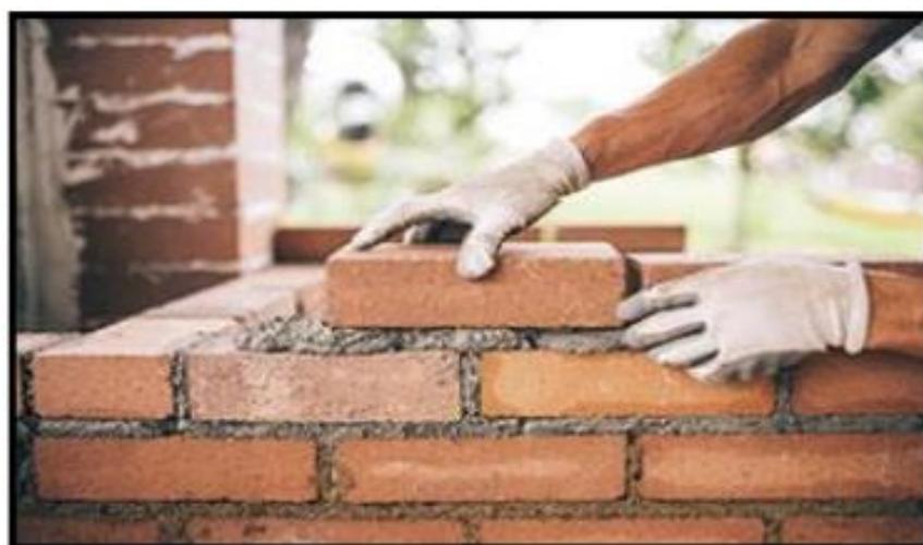
Figura 7. Mortero usado en asentamiento de ladrillos
