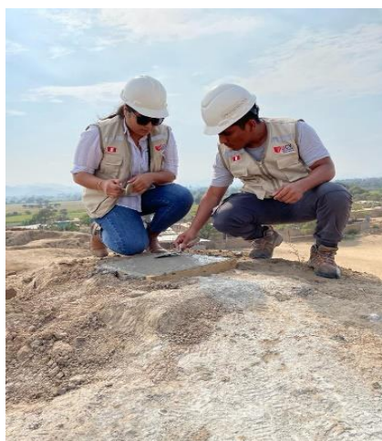
Figura 34: Colocación de BM1
