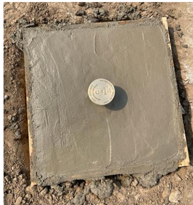
Figura 37: Colocación de Base BM1
