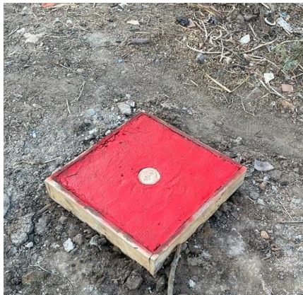
Figura 36: Colocación de BM2
