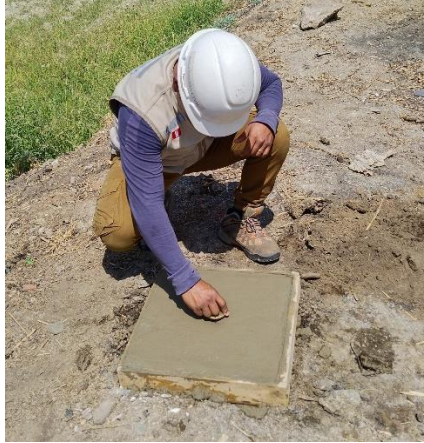
Figura 35: Colocación de BM2
