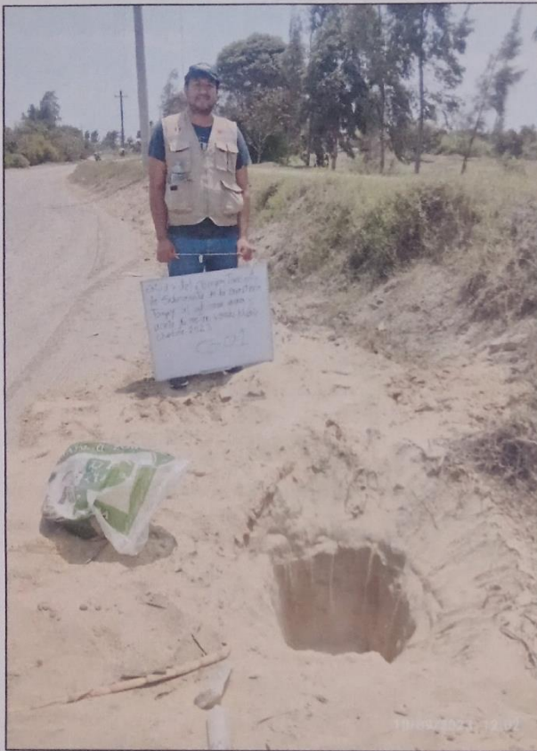
Figura 2: Excavación de calicata C-01
