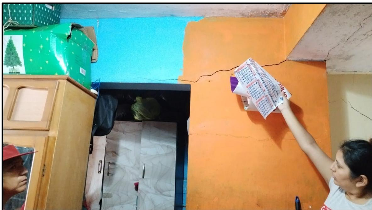
*Figura n.10* Grietas en muro portante.
