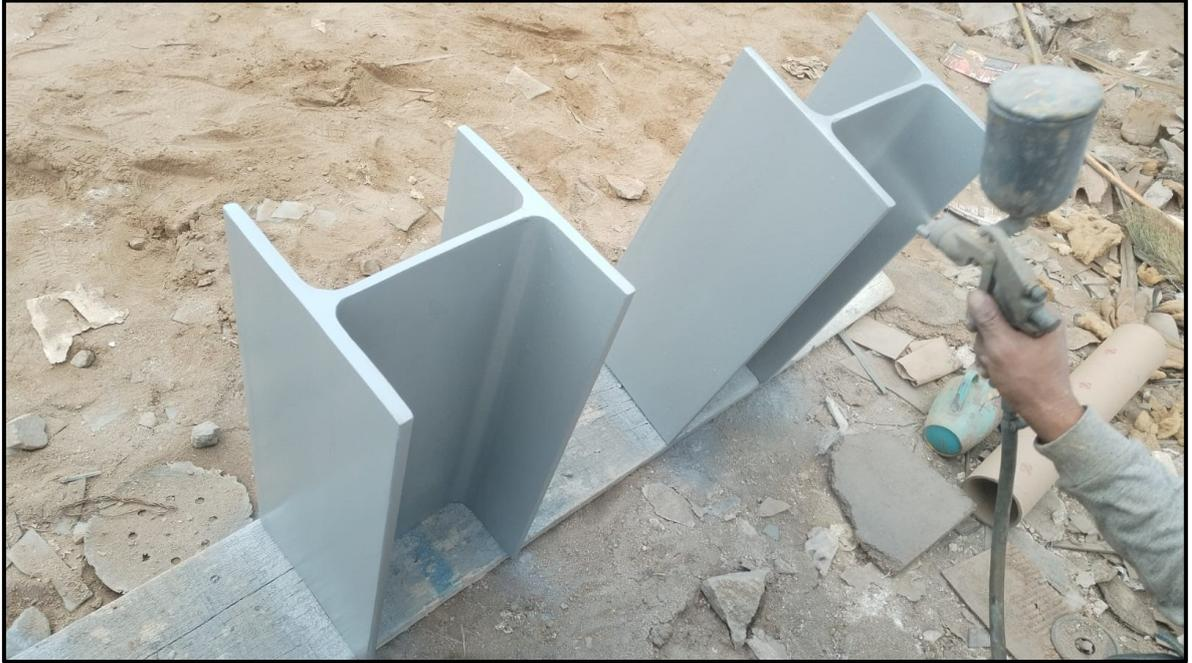
*Figura n.41* Perfiles H – W8X31, base epoxica.
