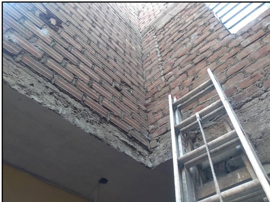
*Figura n.6* Falta de columna.
