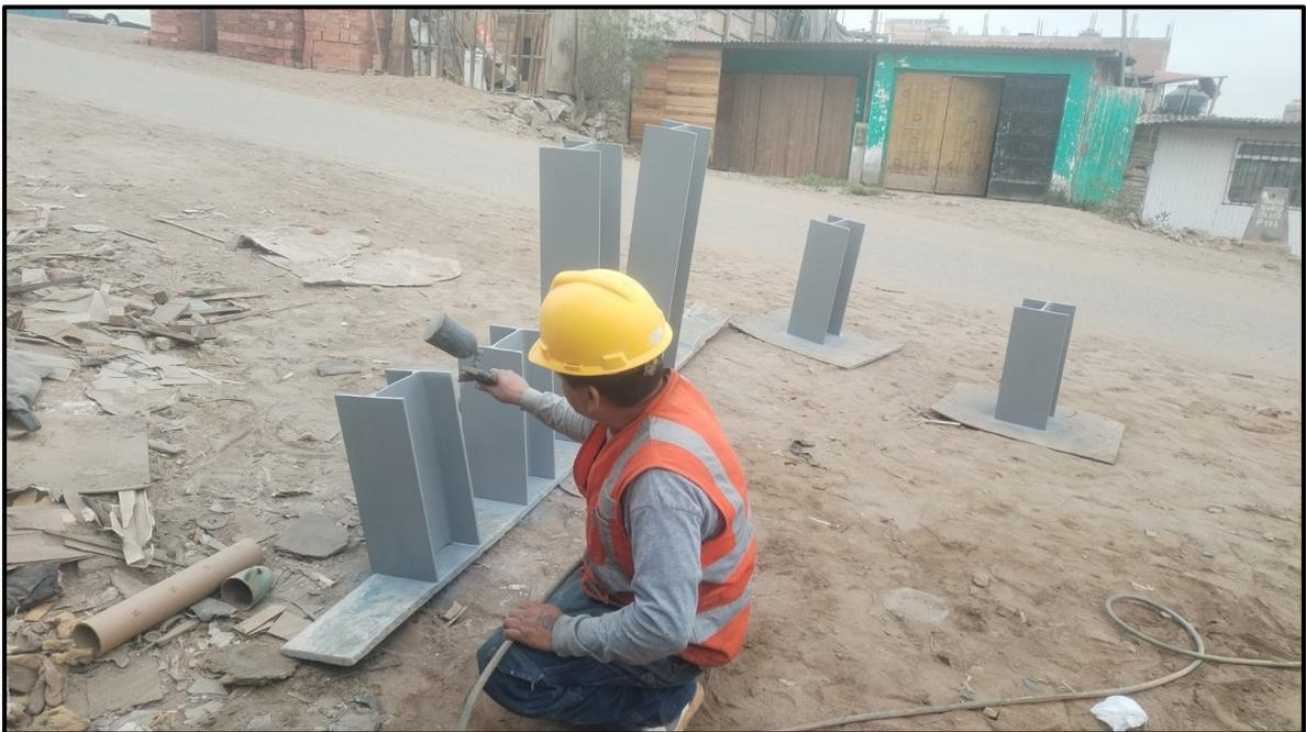
Figura n.40 Perfiles H – W8X31, base epoxica.
