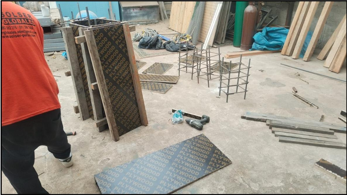
Figura n.35 Encofrado con panel fenólico de 12mm
