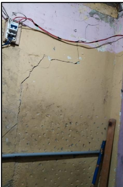
*Figura n.9* Fisuras en muro portantes
