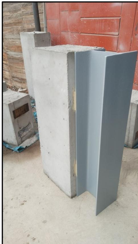
*Figura n.42* Armado del reforzamiento con perfiles H.
