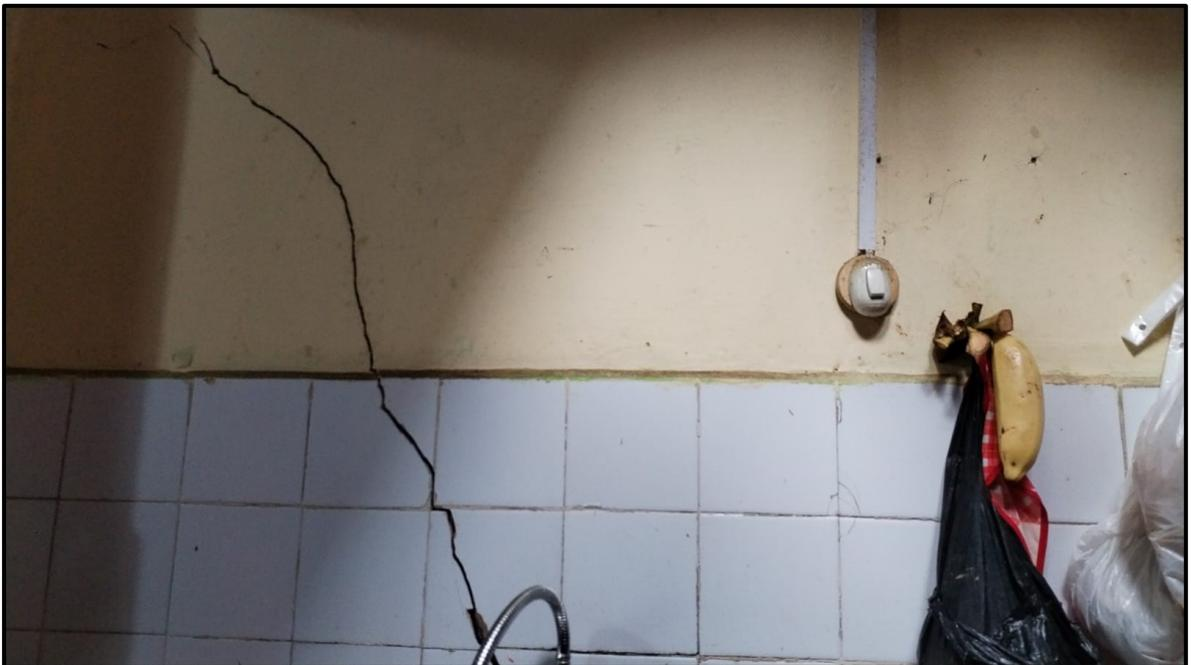
*Figura n.8* Grietas en muro portante.
