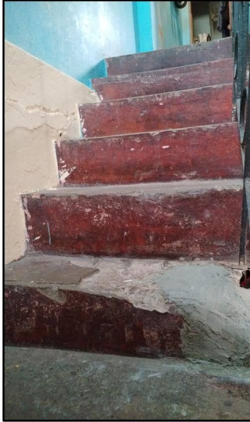
*Figura n.7* Escalera sin ancho reglamentario, estrecha para acceder al segundo nivel.
