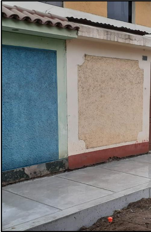
*Figura n.11* Viviendas sin juntas sísmicas.
