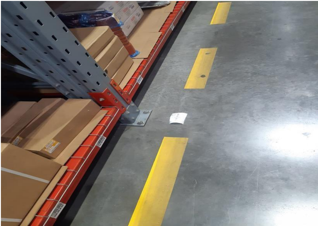
Figura 5. Señalización sucia en el área
