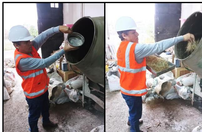
Figura 8. Elaboración de mezcla de concreto  $f'c = 280 \text{ kg/cm}^2$
