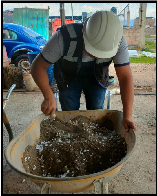
Mezcla de material adicionado poliestireno.
