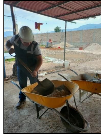
Figura 8. Mezcla de materiales.
