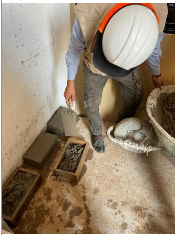
Fotos nº 25-26: En las imágenes podemos observar el moldeo de los bloques de concreto.
