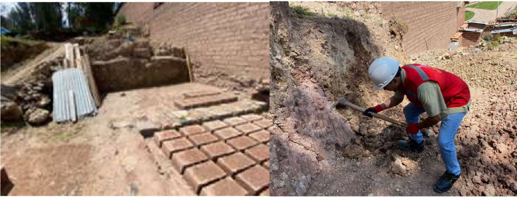
Figura 21: Obtención de los suelos para la fabricación del adobe
