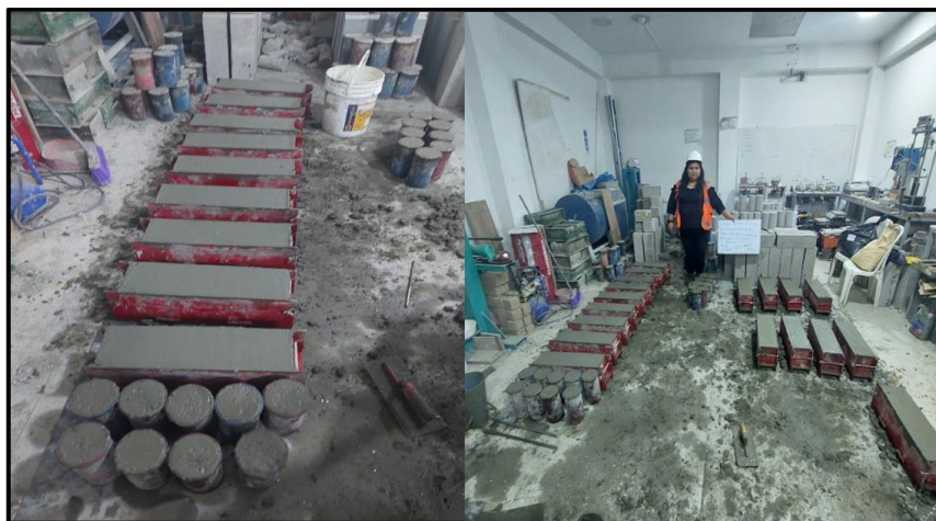
Figura 13. Vaciado y curado
