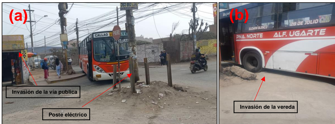
Figura 14. Interferencia de poste eléctrico e Invasión de veredas por parte de vehículos. Fuente: Elaboración propia
