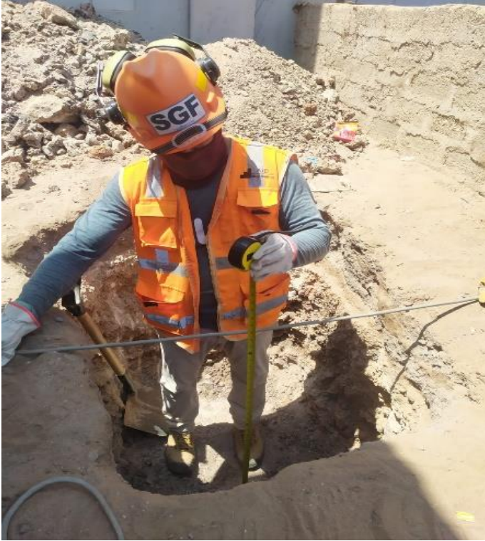
Midiendo el 1er metro de excavación.
