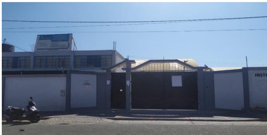
Figura 3 Instalaciones de la I.E José Olaya Balandra
