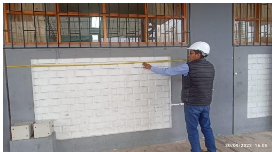
Figura 1 : Ladrillo tipo King Kong 18 huecos en muros.
