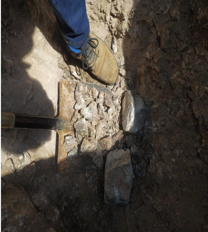
Trozos de roca por la perforación con la herramienta automática el taladro rotomartillo
