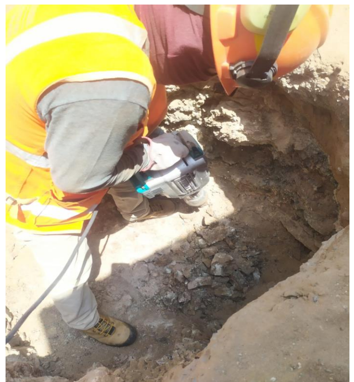
Se sigue encontrando piedras a los 1.50 m de profundidad.
