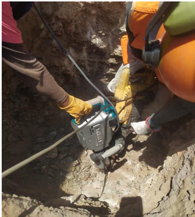
A los 1.20 m de profundidad el taladro rotomartillo empieza atorarse en ocasiones, a causa de las piedras encontradas
