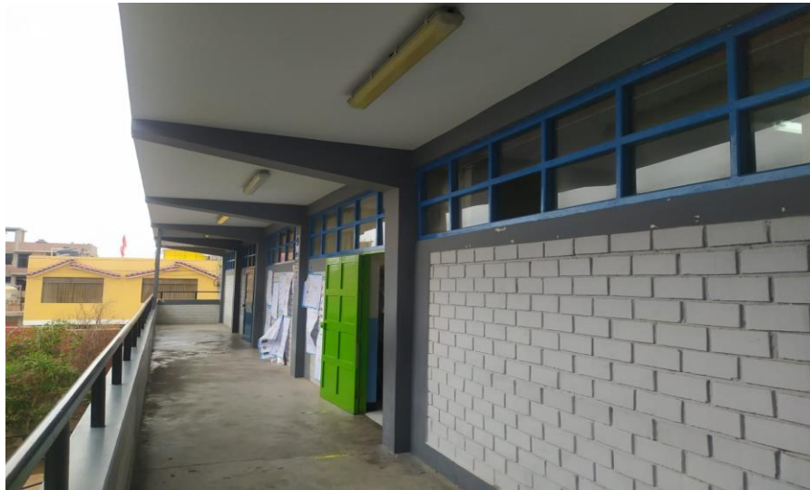
Figura 4 Materiales Utilizados en la construcción.
