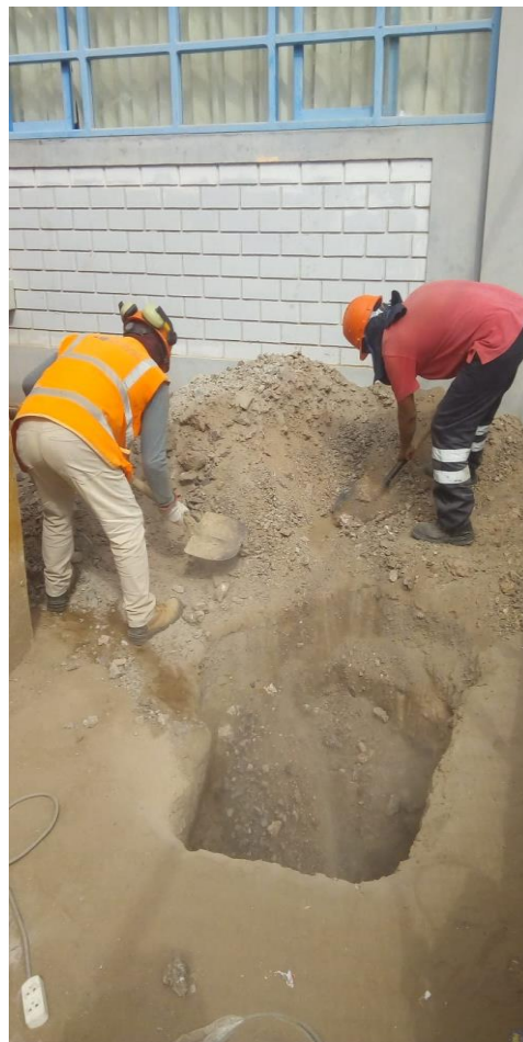
Por último, se procede a tajar la calicata con herramientas manuales.
