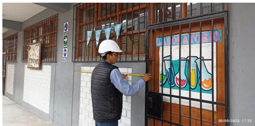
Medrado de muros, columnas, vigas del pabellón "D".
