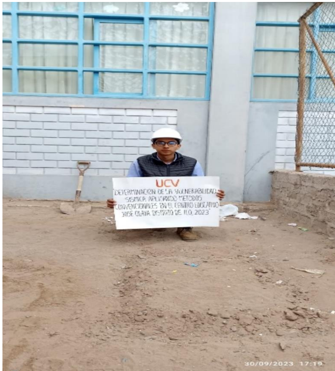
Localizando y trazando el área a excavar la calicata.
