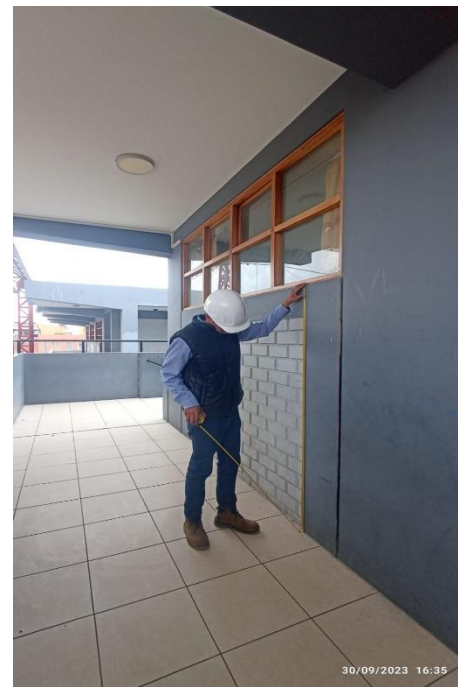
Medrado de altura de muro del 2do piso.
