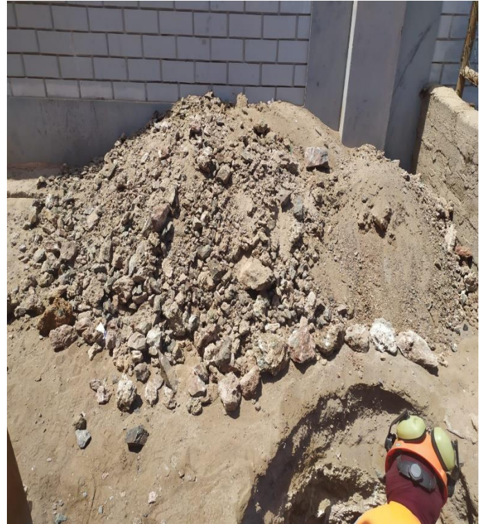
Acopio a causa de la continua excavación de la calicata.
