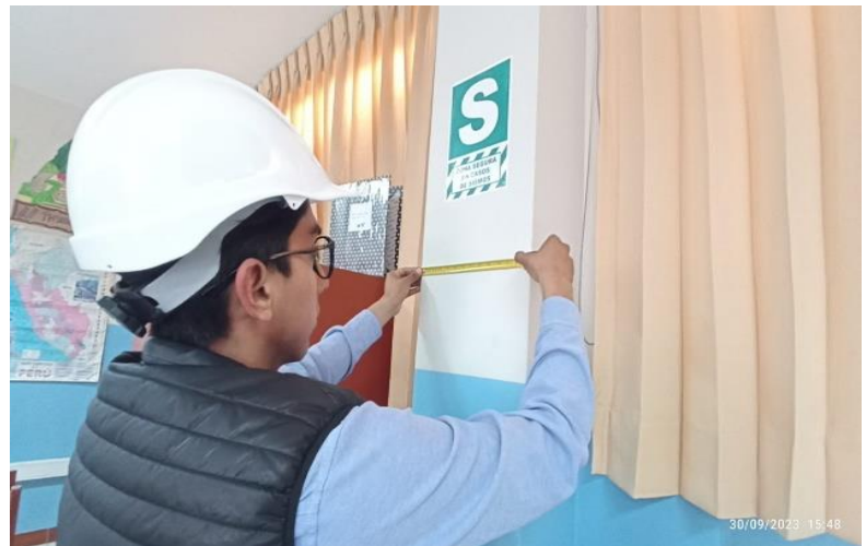
Metrado de viga tipo "T"
