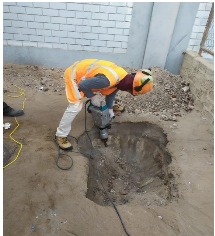
Continuando excavando utilizando pala y taladro rotomartillo demoledor de 1700W industrial
