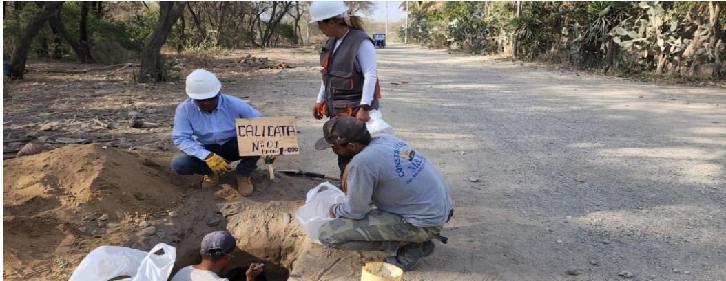
Figura 8. Estudio de Mecánica de Suelos.
