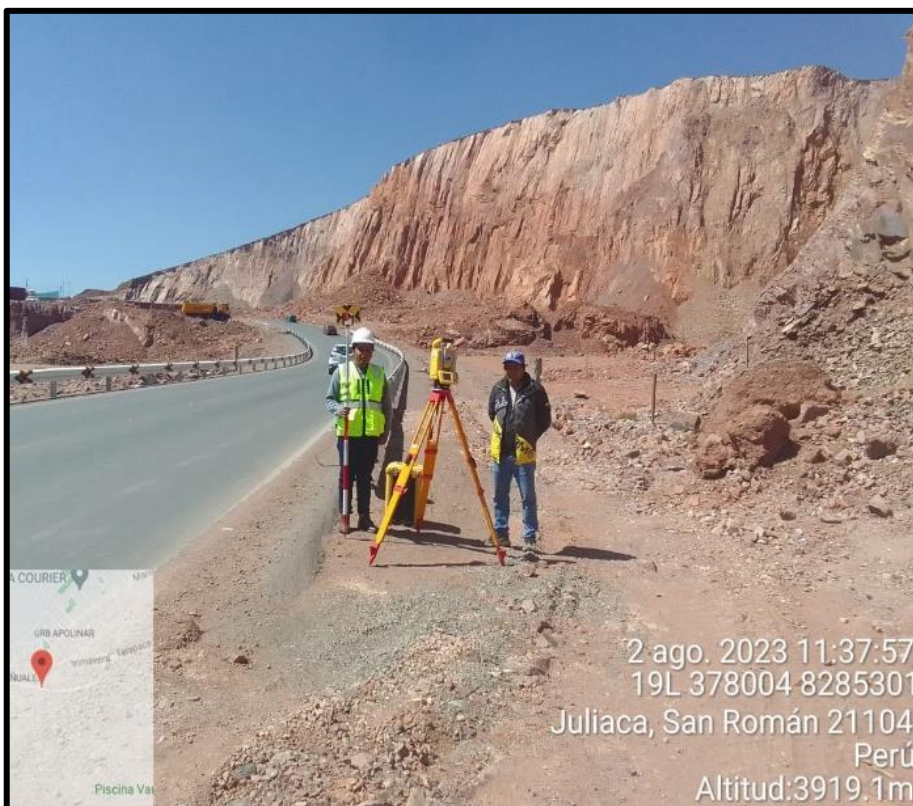
Figura 18. Fin de trabajos de recolección de la topografía de la vía.
