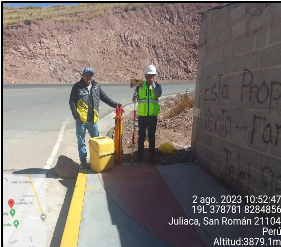
Figura 17. Inicio de trabajos de recolección de la topografía de la vía.
