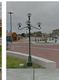
Postes de luces
