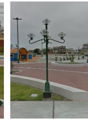
Postes de luces
