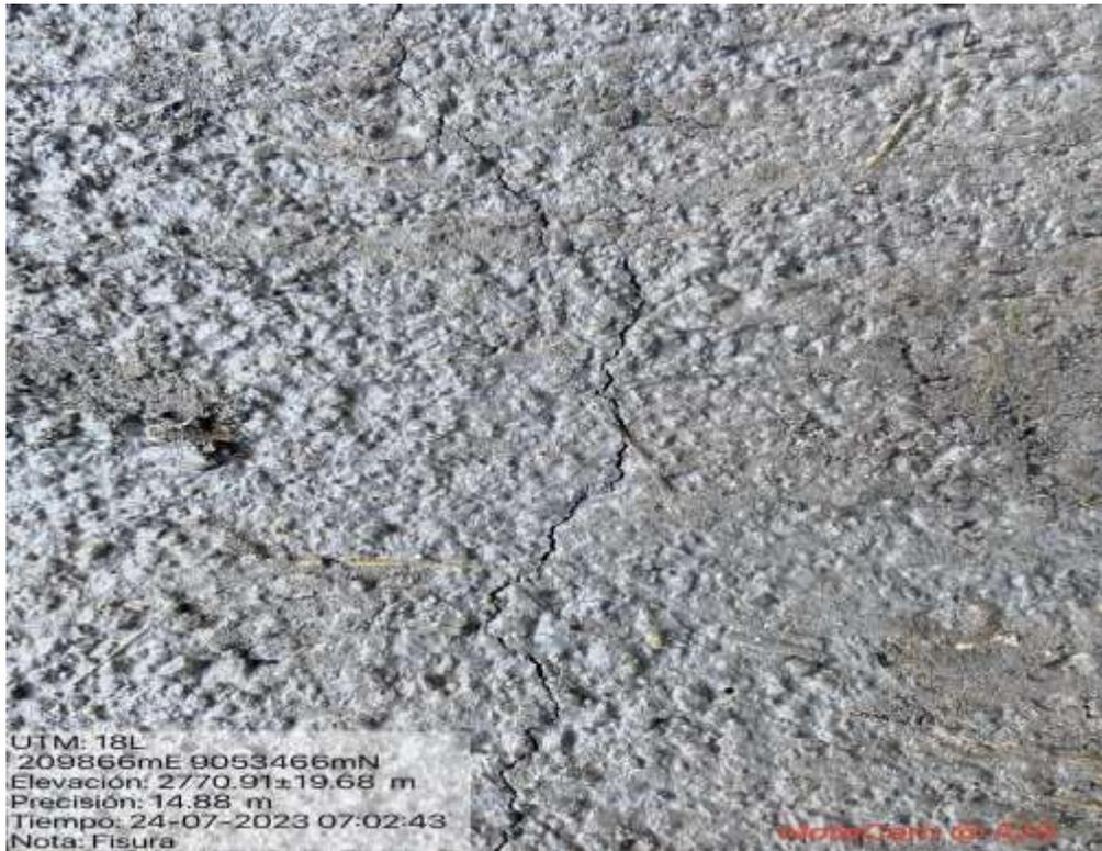
Fotografía 8: Aparicion de fisuras
