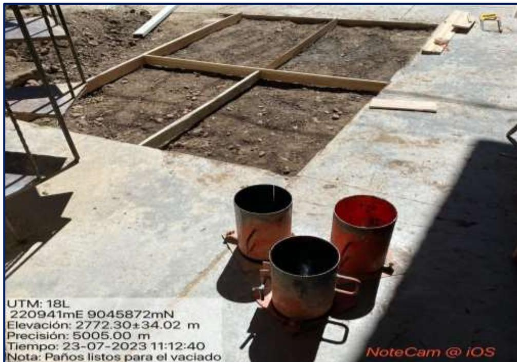
Fotografía 03: Vaciado de los cuatro paños con el paño patrón y los demás con adición de ichu stipa.
