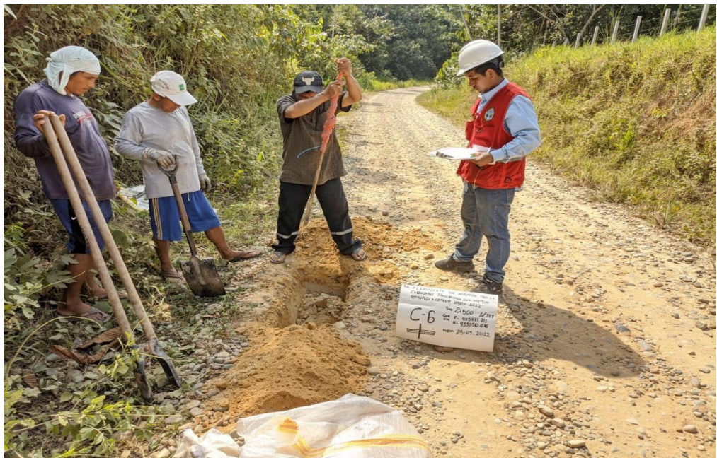
Foto 06. Excavación de calicatas.
