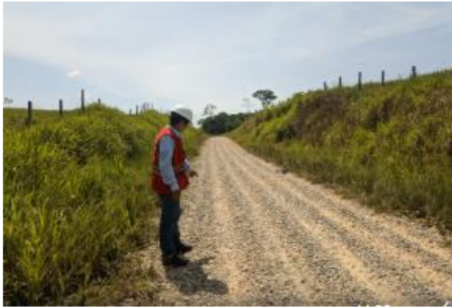
Figura 6: Inspección in situ de la trocha Fuente: Elaboración propia
