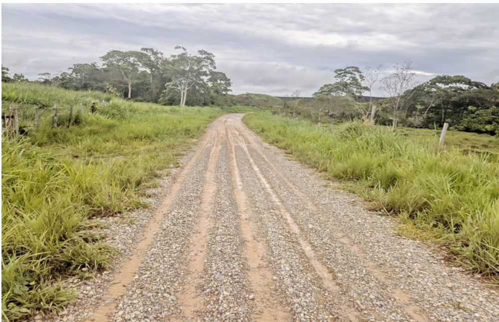
Foto 02. Vista del estado situacional de la trocha.
