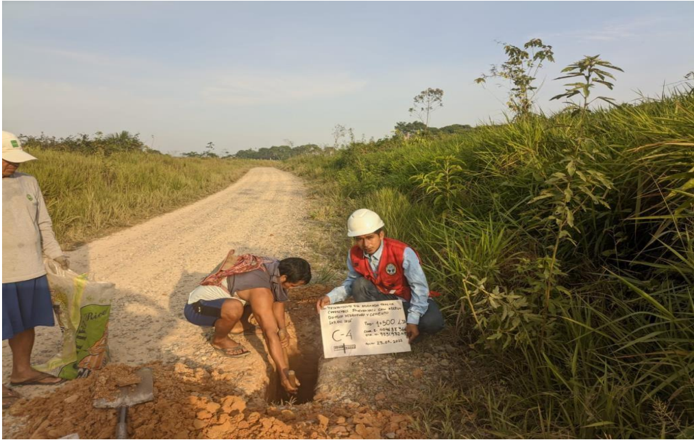
Foto 05. Excavación de calicatas a cielo abierto.
