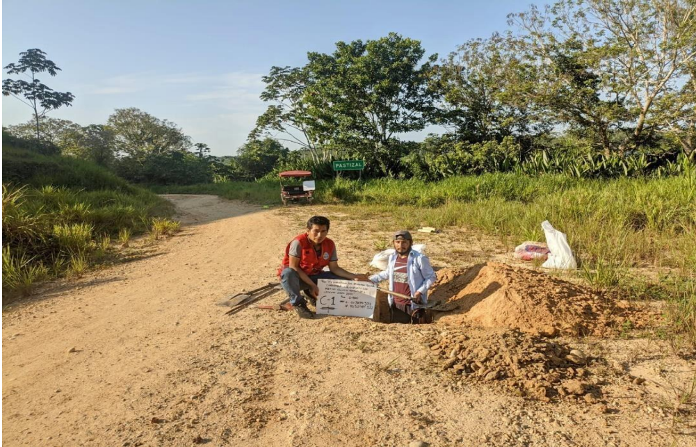
Foto 03. Excavación de calicatas.
